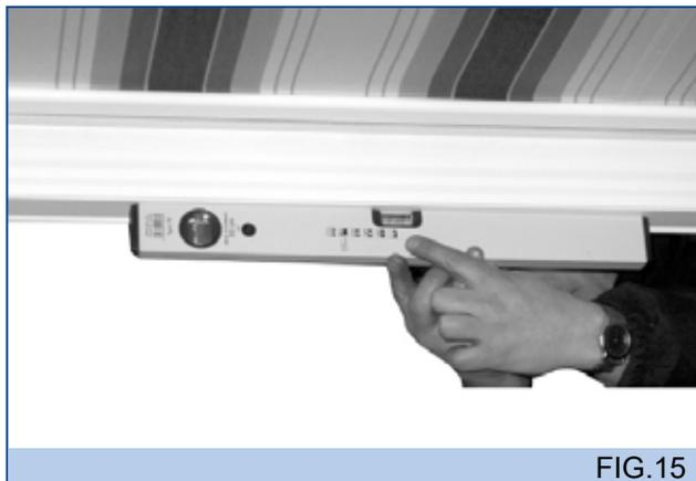
17 = Con l'aiuto di una livella, controllare che il terminale sia in posizione orizzontale. In caso contrario, regolare la vite del supporto corrispondente al braccio fuori livello, con la procedura sotto descritta.
